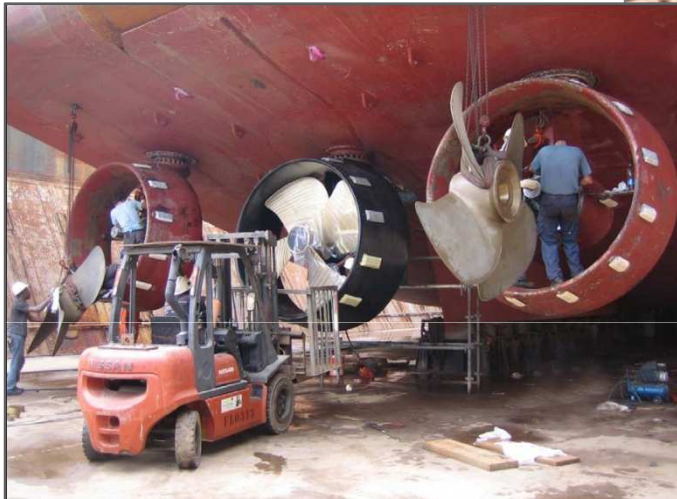
Bourbon Liberty 225 Remplacement du propulseur
